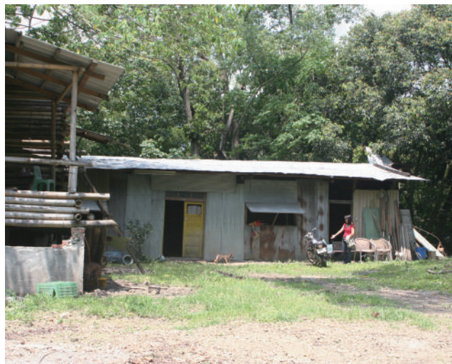
▲ 拆除前的悟洞工寮
