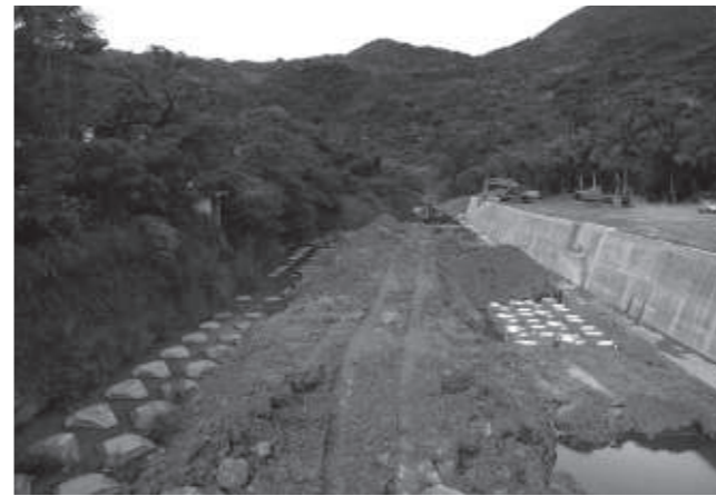
◀ 河岸的植被被剷除，築起高牆。
