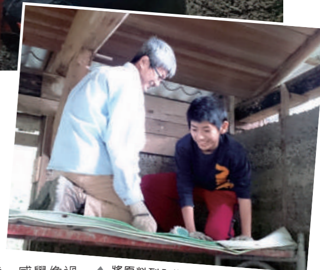
▲ 將原料到入模板內夯牆壁，為了建造冬暖夏涼的牆壁，忍著手酸也很開心。
