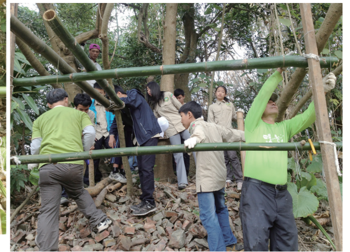
▼ 第二次造訪，合力搭建觀景台
