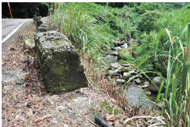
▲ 圖 6 竹 35 旁的小溪流入寶山水庫寶二水庫
