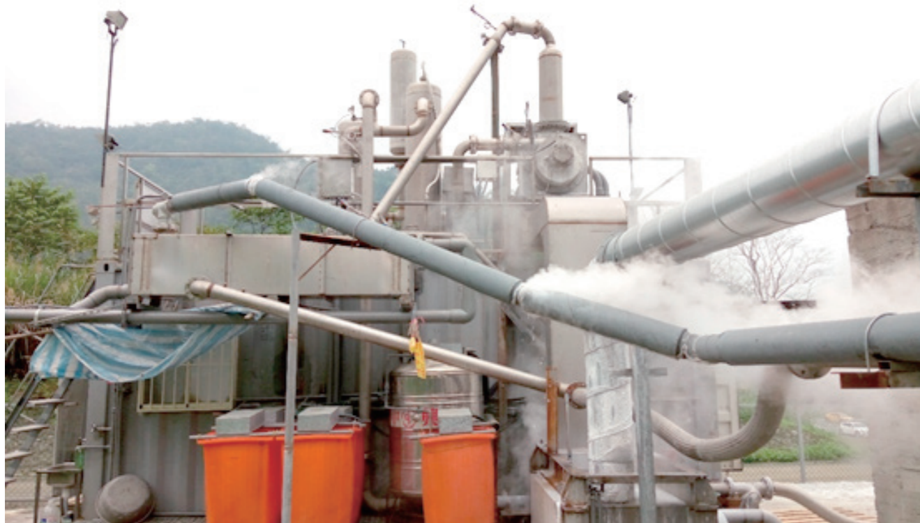
▲ 清水地熱9號井的全流式發電機
