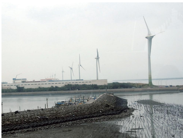
▲ 彰濱工業區旁的小漁港與成排的風機
