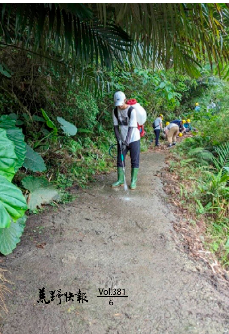
▲ 夥伴們用加壓水柱與人工方式清除路面青苔與積泥
