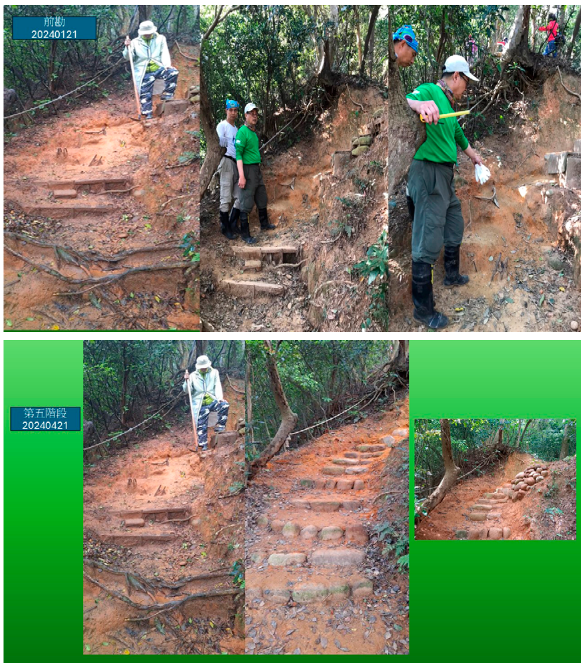
▲好漢坡段施作（施工前與施工後）
