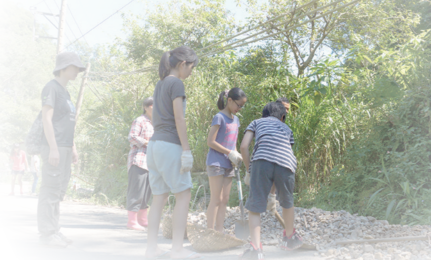
▲ 夥伴們一次次合力搬運石頭到溪溝邊，再下到溝渠進行砌石
