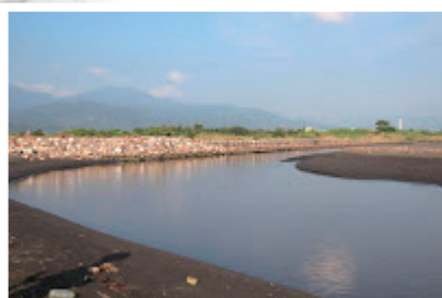
▲ 剛人工整治完成的新城溪出海口
