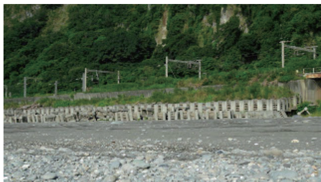
▲ 岸邊散佈著蘇花改善工程材料
