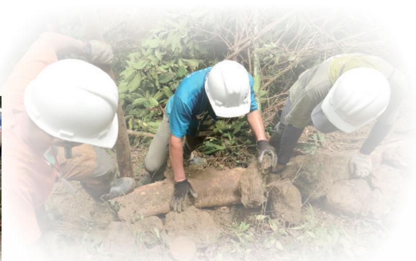
▲ 路面下方仔細回填塊石，給步道穩固的基礎
