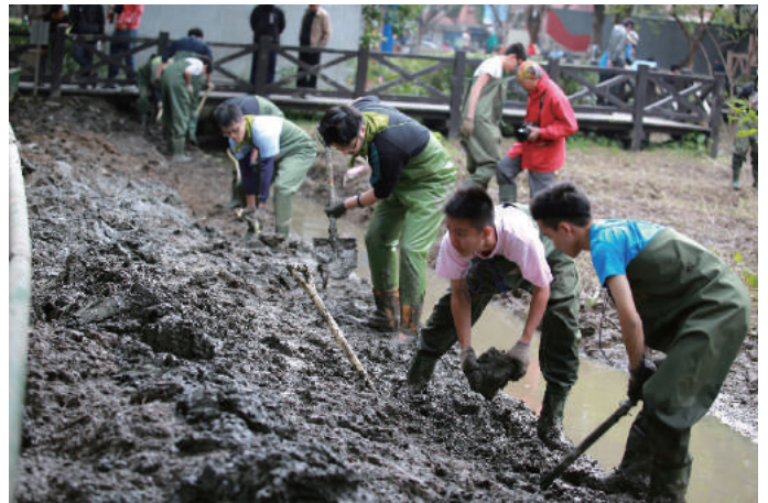
▲ 優化榮星公園生態池時，以人力夯踩(晶化)池底與池岸結構
