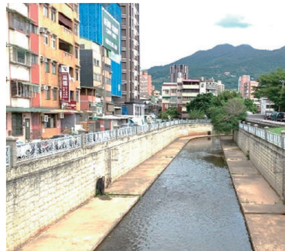
▲ 以水泥包覆、俗稱的「三面光」河道工程 (圖引自《台灣好新聞》)
