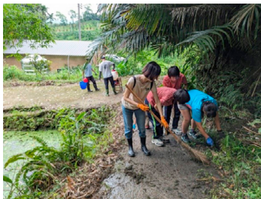
▲ 夥伴們用加壓水柱與人工方式清除路面青苔與積泥
