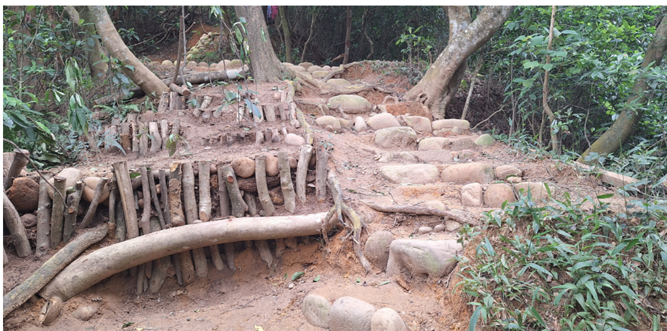
▲ 橫木護坡保護樹木施工後
