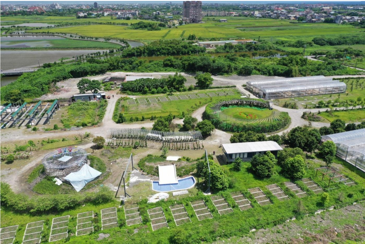
業者違法於五十二甲濕地內大興土木，包含滑水道及游泳池、花鐘、大型溫室等建物。
